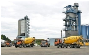
ООО «ВЕЛКОМ-ГРУПП» асфальтобетонный завод
