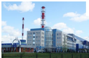
ПАО «Квадра» парогазовая установка (ПГУ-115 МВт) на Дягилевской ТЭЦ
