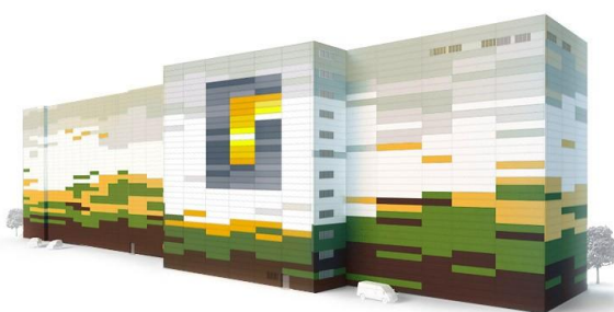
АО «Рязаньзернопродукт» цех фасовки со складом
