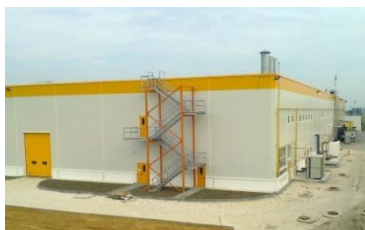
ООО «Аутомотив Лайтинг» производственный комплекс «Автомобильные фары» (II этап)
