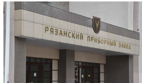
АО «Государственный Рязанский приборный завод» техническое перевооружение
