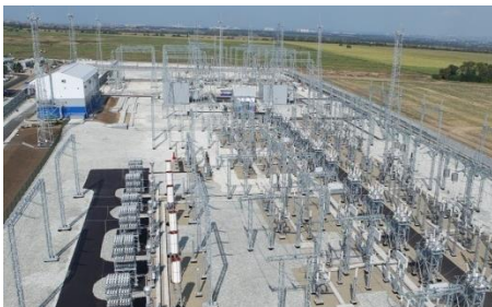
ПАО «ФСК ЕЭС» реконструкция и комплексное перевооружение ПС «Ямская»
