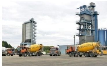
ООО «ВЕЛКОМ-ГРУПП» асфальтобетонный завод
